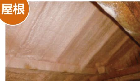
屋根の勾配に沿って断熱材を吹き付けします。輻射熱の激しい屋根下や天井裏への施工によって特に夏場の冷房効率が改善され、家全体の断熱性が飛躍的に良くなります。
