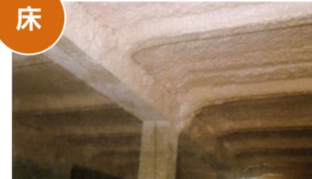
床裏に断熱材を吹き付けし、床上に熱が伝わらないようにします。
