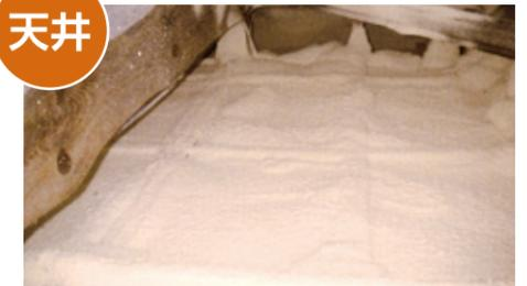
天井の上に断熱材を吹き付けします。天井点検口から工事を行うため、他の工事と絡みませんので、比較的容易にできます。その分コストも抑えられます。
